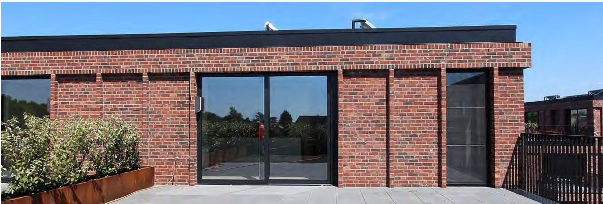
Mengeling (50/50) lichtgenuanceerd rood ruw en rood bont wdf met voeg
